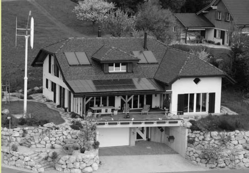
Liegenschaft mit Sonnenkollektoren, Photovoltaik- und Windkraftanlage in Barzheim
